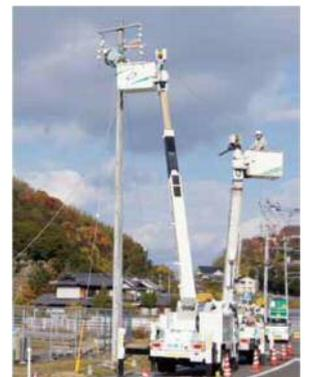
高所作業車を使用した配電線作業
