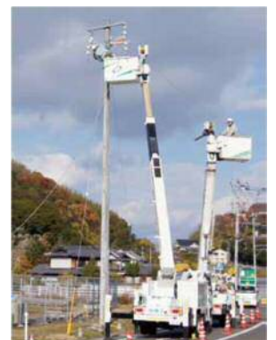
高所作業車を使用した配電線作業
