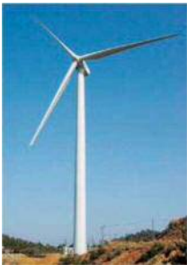
生湯風力発電所
