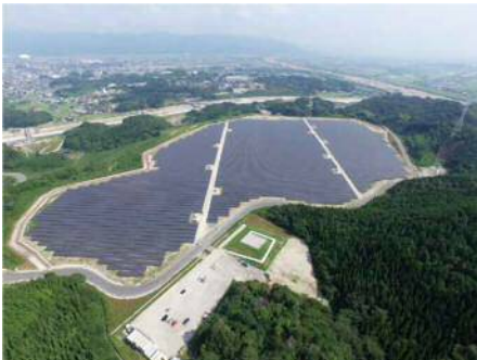
出雲クリーン発電太陽光発電所
