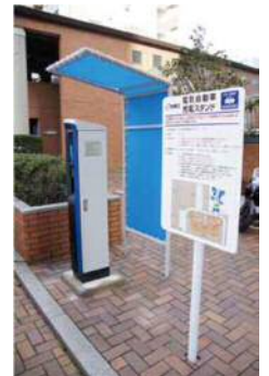
電気自動車の充電設備
