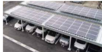
駐車上の屋根を利用した太陽光発電システム
