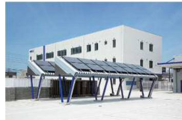
駐輪上の屋根を利用した太陽光発電システム
