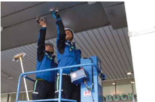
松江駅バス停照明器具点検、清掃 (島根統括支社)
