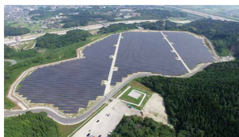
出雲クリーン発電太陽光発電所(2015年竣工) パネル枚数51,500枚／太陽電池容量約12.5MW
