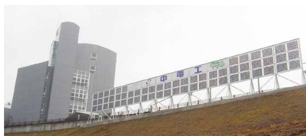
2007年に当社研修所に導入した垂直設置型両面受光太陽光発電設備
