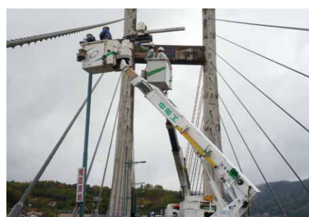
木次大橋イルミネーションの電気設備点検・清掃 (雲南営業所)
