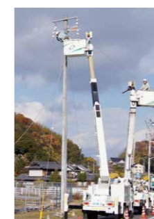
高所作業車を使用した配電線作業
