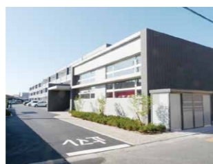
新築の岡山寮(2015年11月竣工)
