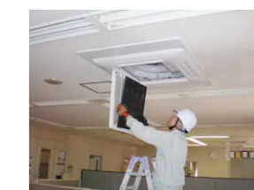
エアコンフィルタ清掃 (高梁営業所)
