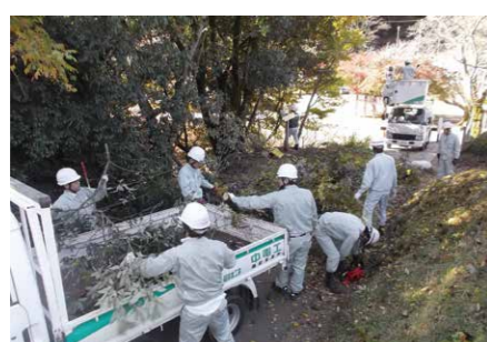
備前市関谷周辺の樹木伐採 (備前営業所)
