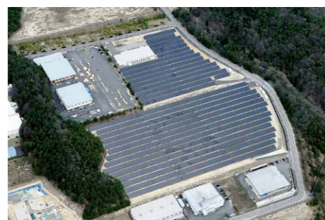
当初のメガソーラー施工 氏神工業団地メガソーラー(2013年竣工)
