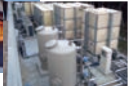
▲給水・ろ過設備
