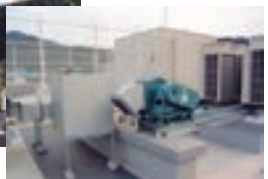
▲排気ファン設備
