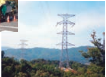
送電線新設工事
