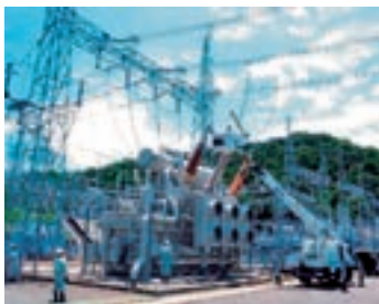
変圧器取替工事 (発送変電工事)
