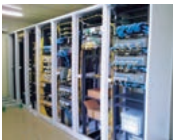
通信事業者 局舎内ネットワーク 整備工事 (情報通信工事)
