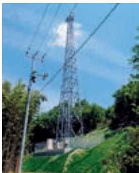
携帯電話基地局設置工事 (情報通信工事)
