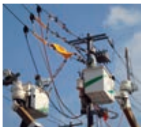
高圧間接活線工法での 径間途中切り分け工法による 工事用開閉器取付工事 (配電線工事)
