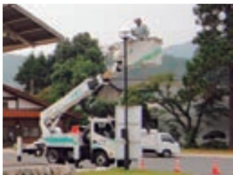
▲高所作業車を使った屋外照明灯の清掃
