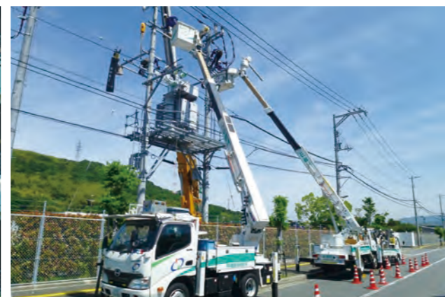
3 22kV変圧器撤去作業
