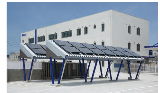
駐輪場の屋根を利用した太陽光発電システム
