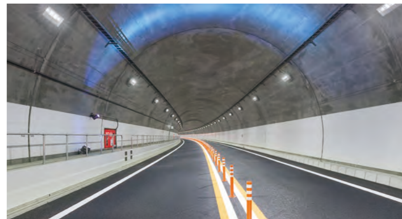
2 中部横断自動車道 宮狩トンネル【照明設備工事】(山梨県西八代郡)
