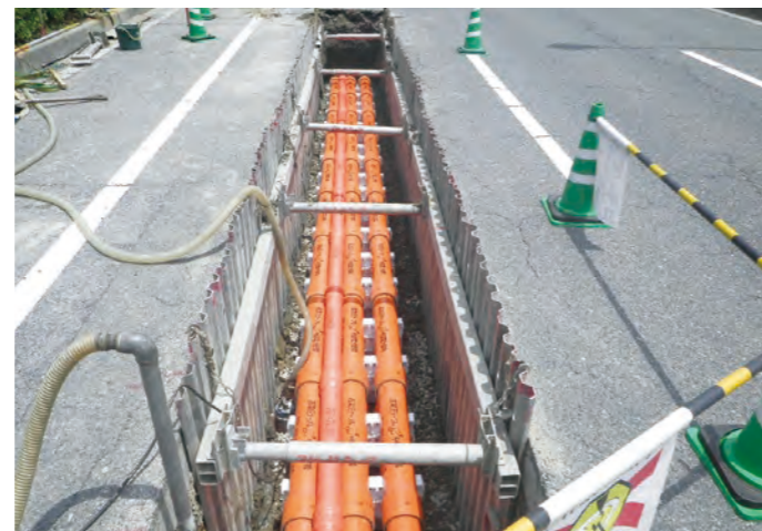
3 南広島観音線【地中送電線工事】 (広島県広島市)
