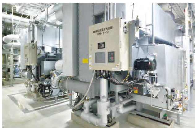
2 鳥取赤十字病院【熱源供給設備工事】 (鳥取県鳥取市)
