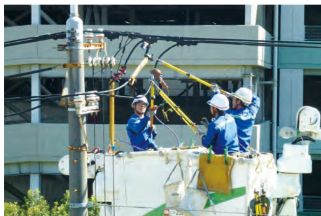
2 高圧線を間接活線工法にて接続
