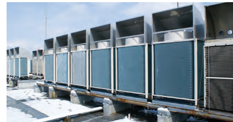
工場の屋上に設置された高効率ヒートポンプ空調室外機
