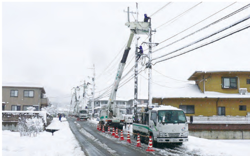
1 架空配電線工事現場作業
