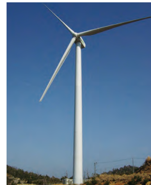
生湯風力発電所（島根県浜田市）
