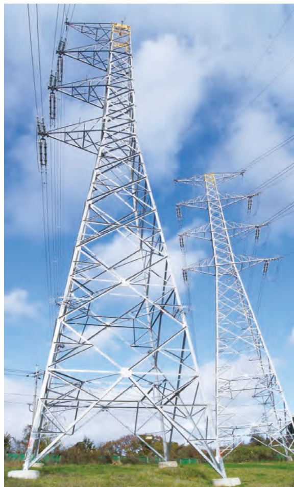
1 井原連絡線・新岡山連絡線【架空送電線工事】 (岡山県岡山市)
