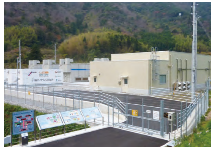
2 西ノ島変電所【発電所工事】 (島根県隠岐郡)
