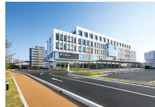
3 医療法人創起会くまもと森都総合病院【電気設備工事】(熊本県熊本市)
