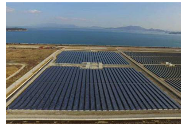
東野崎太陽光発電所
