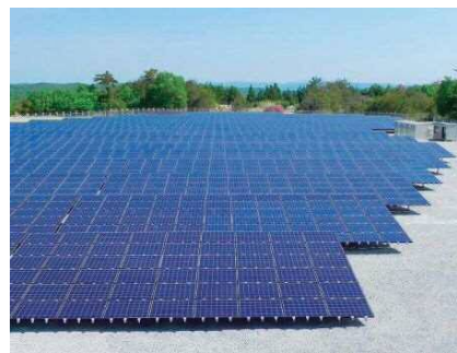
太陽光発電設備工事
