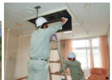
▲特別養護老人ホームの空調機器清掃
