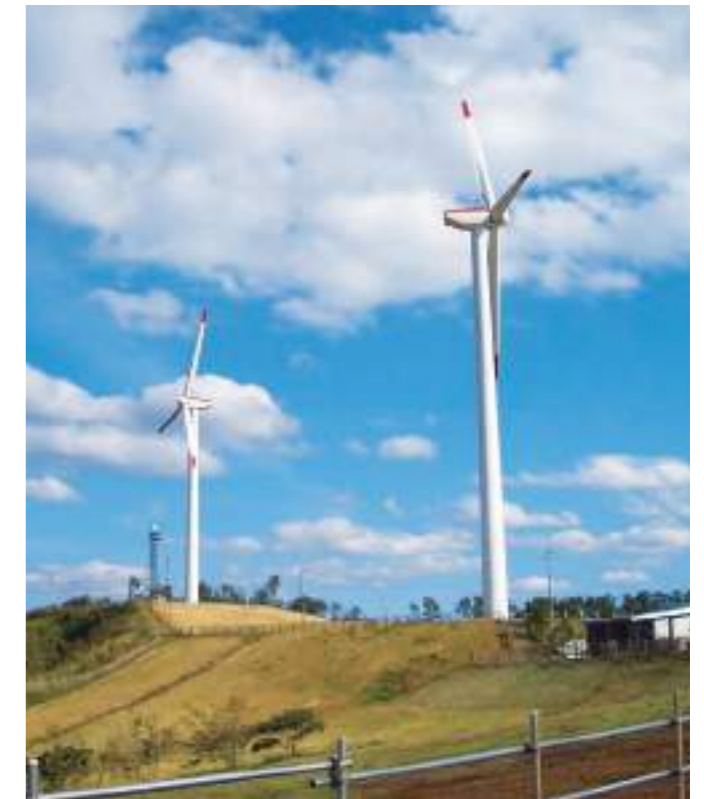
鳥取放牧場風力発電所 (鳥取県) Tottori Pasture Wind Power Plant (Tottori Prefecture)
