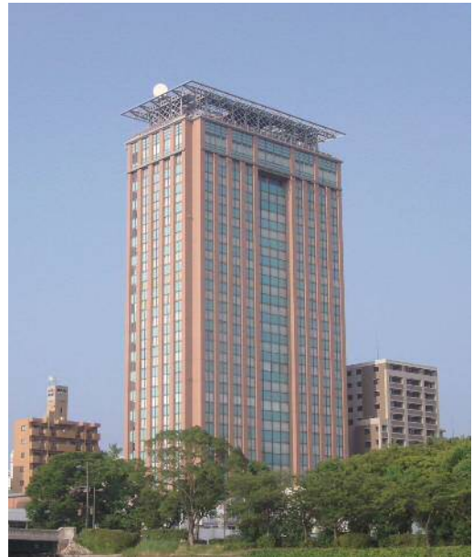
▲中電工平和大通りビル
