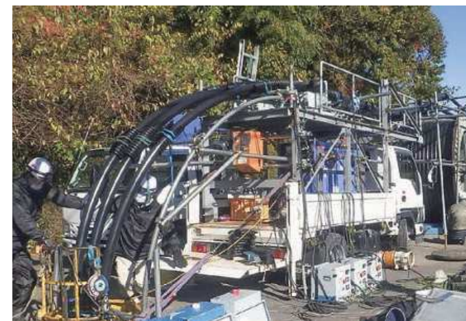
地中送電線工事(ケーブル工事)
