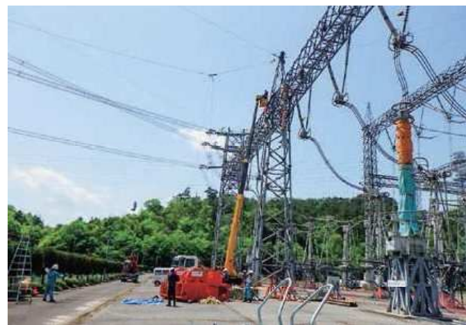
変電所工事(500kV変電所工事)
