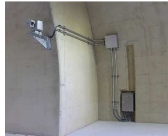
トンネル内CCTV設備
