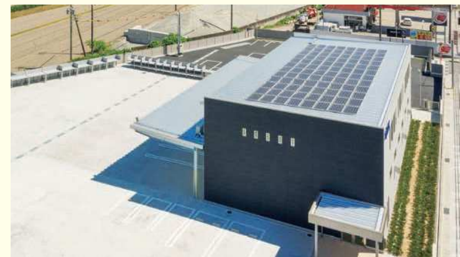
自家消費型太陽光発電設備(金川配電センター)「ZEB」認証取得
