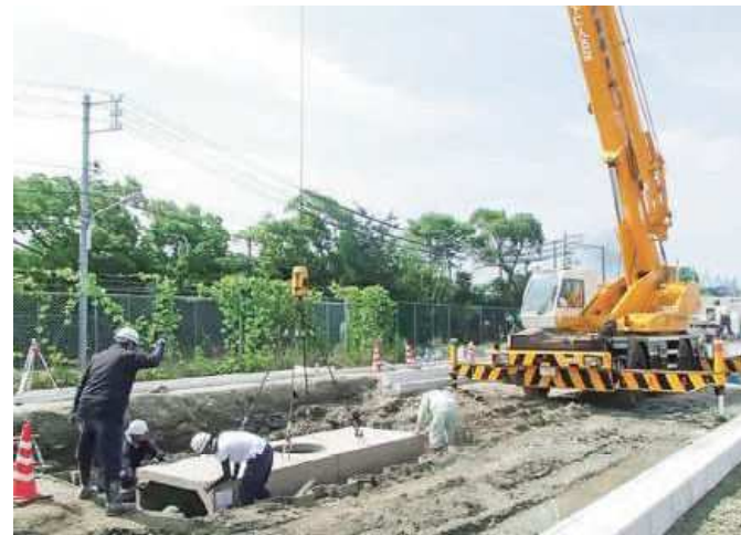
地中配電線工事(マンホール工事)
