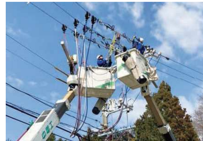
架空配電線工事(径間途中部分で縁開放する停電縮小工法) 径間途中の張力部分で高圧架空線の切り分けを行い、停電縮小する工法です。
