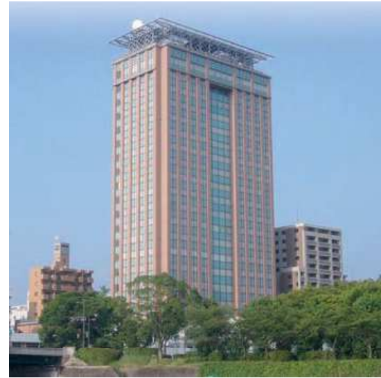
中電工平和大通りビル
