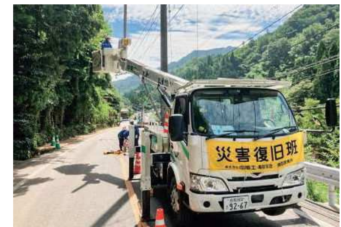
災害停電復旧作業 2023年8月、台風7号による鳥取県内の豪雨災害では、各所で土砂崩れや道路崩落で電柱倒壊がある中、岡山県からの応援を含め迅速に災害復旧班を編成し、停電を早期に解消しました。
