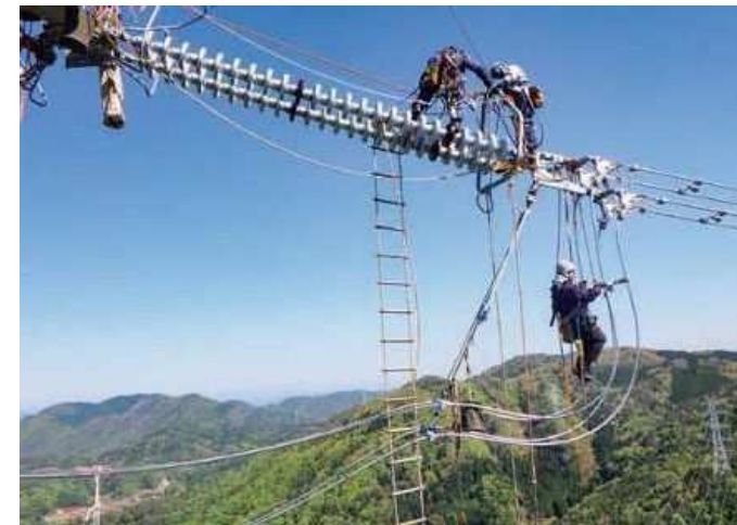
架空送電線工事(鉄塔工事)
