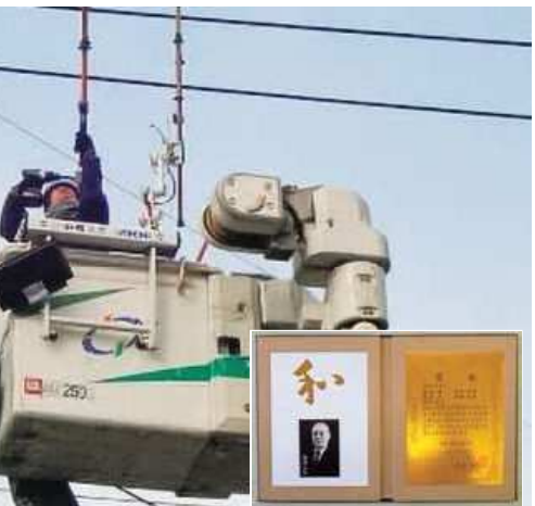
架空配電線工事(ThirdArmを活用した高圧間接活線工事) 高圧間接活線作業はホットスティックを使用して作業します。縁線の把持や電線の揺動防止等の補助者が必要な場合においては、ThirdArmを活用して高圧充電部との離隔を確保し、より安全かつ効率的に作業を行います。また、本工具は第67回濫濁賞を受賞しました。
