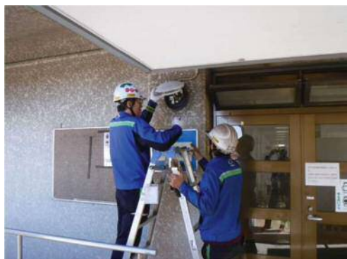
障害者支援施設の照明器具の清掃(水島営業所)
