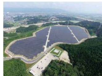
出雲クリーン発電太陽光発電所
