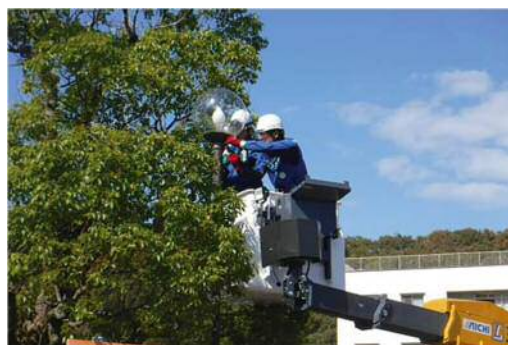
障害者支援施設の外灯の清掃 (笠岡営業所・井笠配電センター合同)
