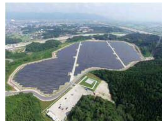
出雲クリーン発電太陽光発電所
