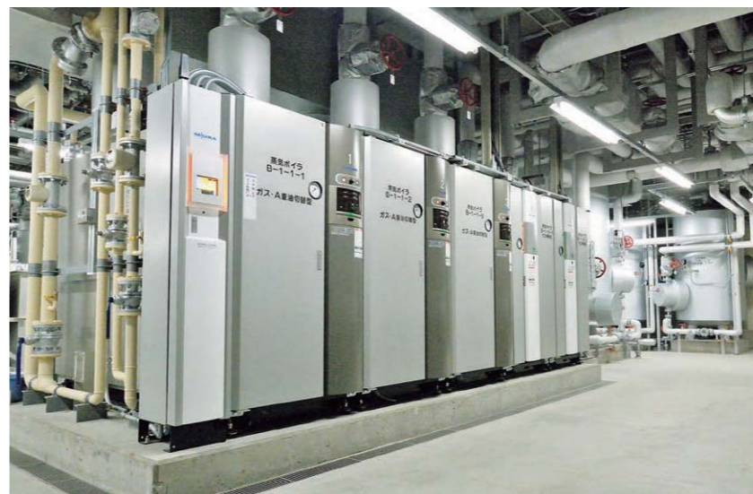
鳥取赤十字病院<熱源設備> (鳥取県鳥取市) Tottori Red Cross Hospital <Heat Source Apparatus> (Tottri City, Tottori Prefecture)
