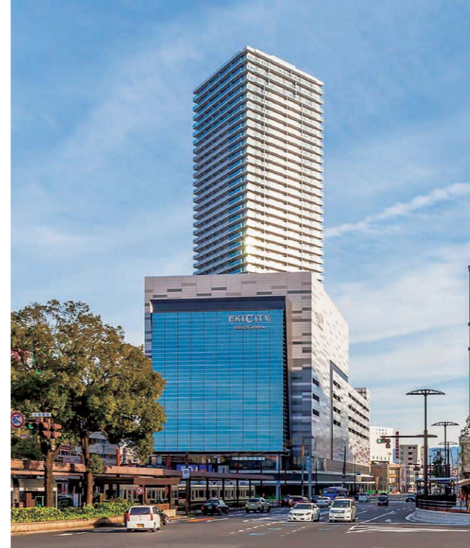
広島駅南口Cブロック第一種市街地再開発事業 (広島県広島市) Hiroshima Station South Exit C block urban redevelopment project (Hiroshima City, Hiroshima Prefecture)
