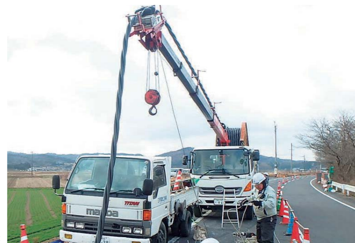
地中線ケーブル入れ作業 Laying power cable into underground conduit
