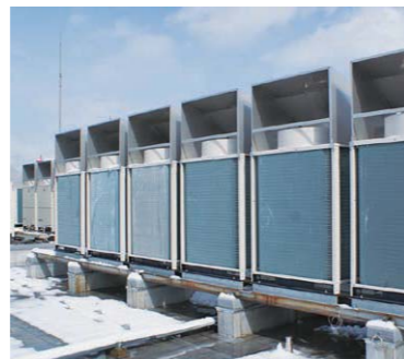
工場の屋上に設置された高効率 ヒートポンプ空調室外機 Highly efficient heat pump air conditioner outdoor unit installed on the roof of the plant
