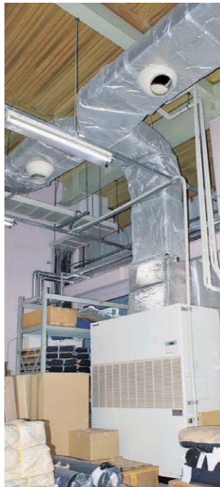
作業ラインの レイアウトに合わせて 最適化した空調吹出し Optimized air conditioning exhaust based on the layout of the work line
