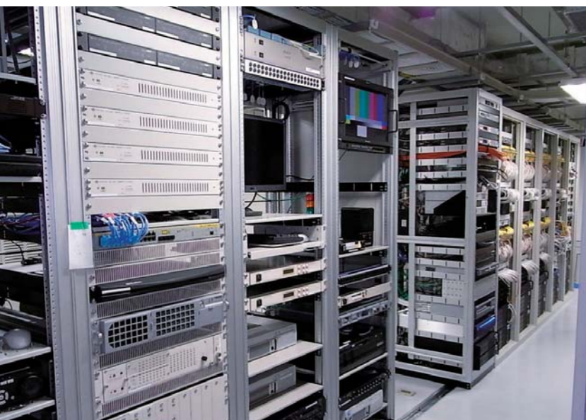
安来市ブロードバンド・インフラ事業 (島根県安来市) Yasugi Broadband Infrastructure Maintenance Work (Yasugi City, Shimane Prefecture)
