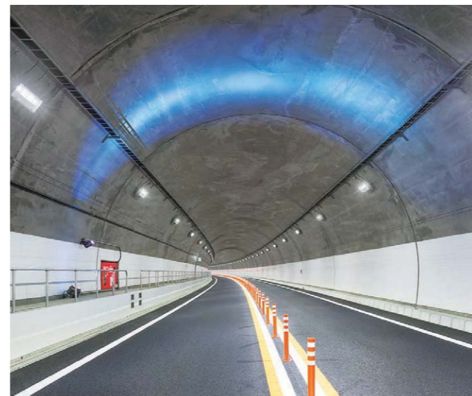
中部横断自動車道 宮狩トンネル (山梨県西八代郡市川三郷町) Miyagari Tunnel on CHUBU ODAN EXPWY (Ichikawamisato-cho, Nishiyatsushiro-gun, Yamanashi Prefecture)
