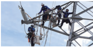
新入社員配電線・送变电教育
