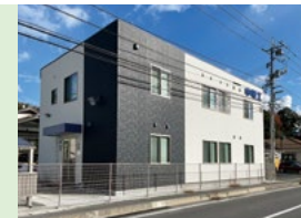
隠岐営業所(新築)
