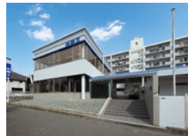
呉営業所(改修)
