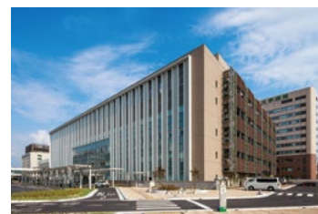
2013年 広島大学病院完成(当社施工)
