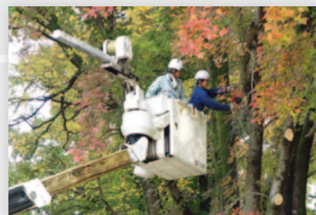
▲高所作業車での樹木伐採
