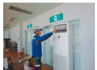
▲避難所へのエアコン設置工事
