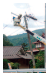
▲停電復旧作業
