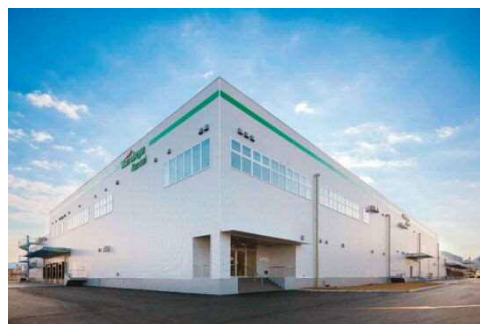
工場関係工事
