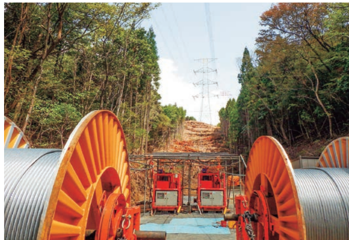
架空送電線工事 (500kV電線張替工事)
