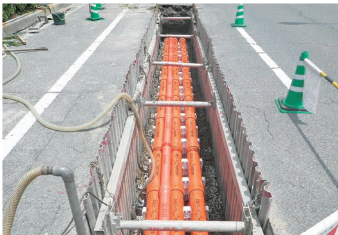
地中送電線工事 (管路工事)
