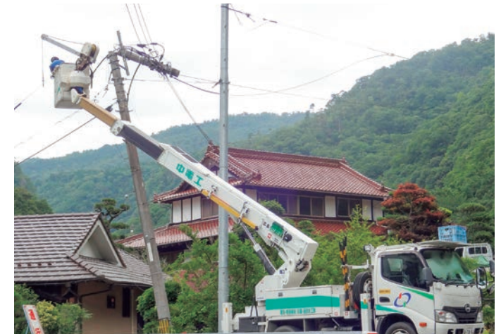
災害停電復旧作業
