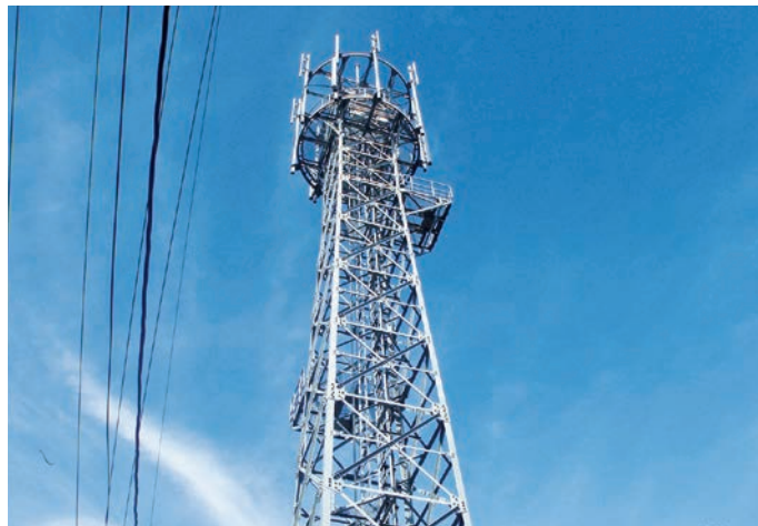
移動体無線通信設備
