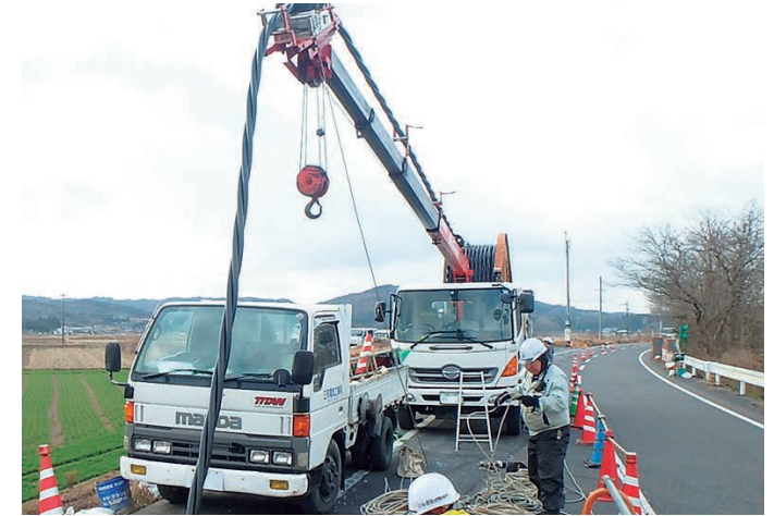
地中配電線工事
