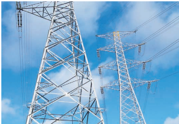
架空送電線工事
