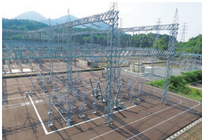
変電所工事 (500kV変電所増設工事)
