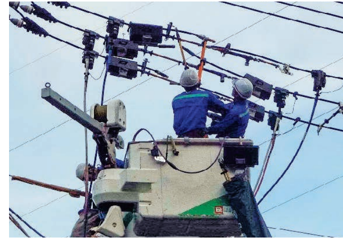
架空配電線工事(径間途中部分で縁開放する停電縮小工法)
