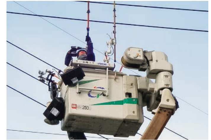
架空配電線工事(ThirdArmを活用した高圧間接活線工事)
