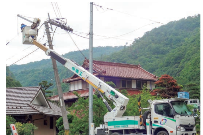
災害停電復旧作業
