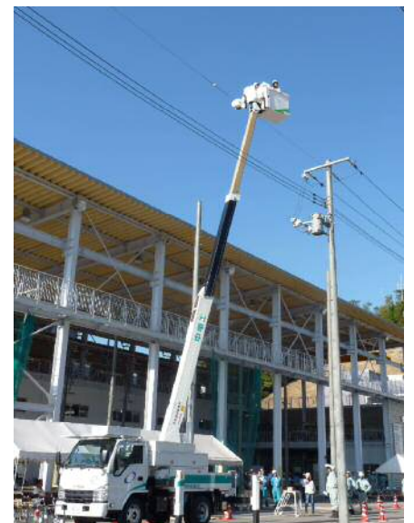
高所作業車試乗体験の様子
