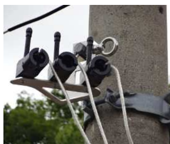
【電柱にセット】
