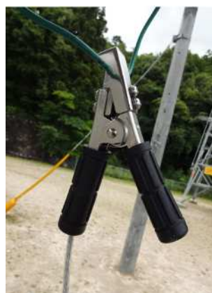
アースクランプを 接地線に取付
