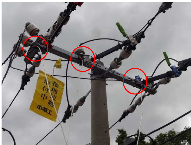
本体クランプを高圧引下線取付
