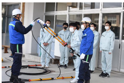
▲ホットスティックの使用の実技指導▲
