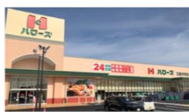
北島中央店（板野郡） 188KW
