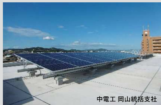
自家消費太陽光発電に蓄電池を組み合わせ、BCPに対応したZEB建築物 ■ 発電容量：33kW
