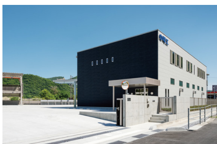
中電工 金川配電センター〈新築〉／『ZEB』
