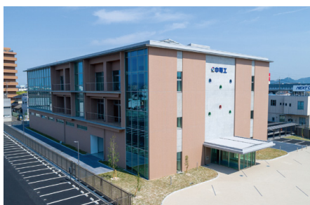
中電工 岡山統括支社〈新築〉／ZEB Ready
