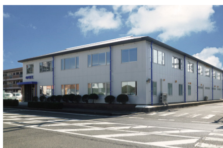
中電工 下関営業所〈改修〉／『ZEB』
