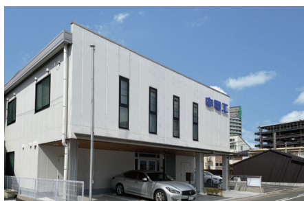
中電工 名古屋支社〈改修〉／ZEB Ready
